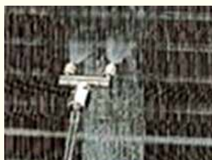
熱交換機(フィン)の洗浄
